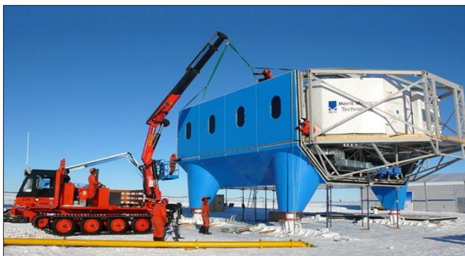
Рисунок 6. Возведение объектов инфраструктуры северного транспортного узла в н.п. Резольют-Бэй
